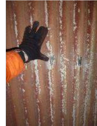
Tubos da Fornalha
