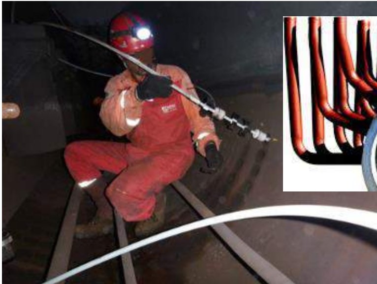
Sonda sendo inserida no Tubulão superior
