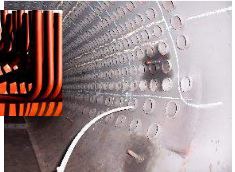
Saindo no Tubulão inferior
