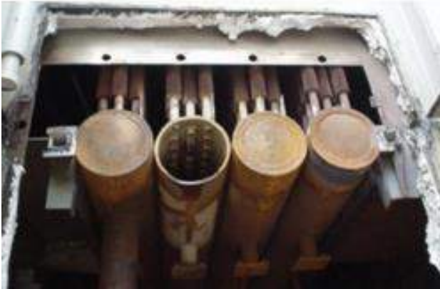
Abertura de acesso no coletor
