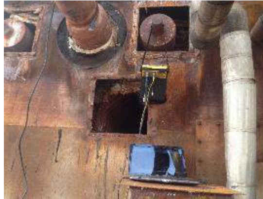
Bocais dos tubulões
