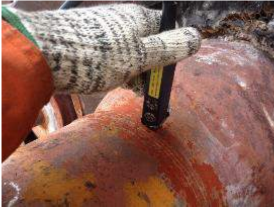
Tubulação de Vapor
