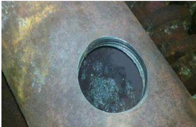
Abertura de acesso no coletor
