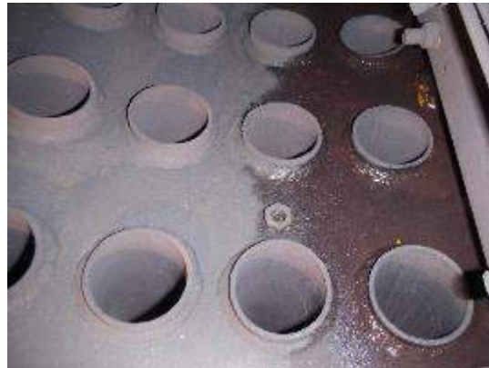
Ligação tubos espelho do tubulão
